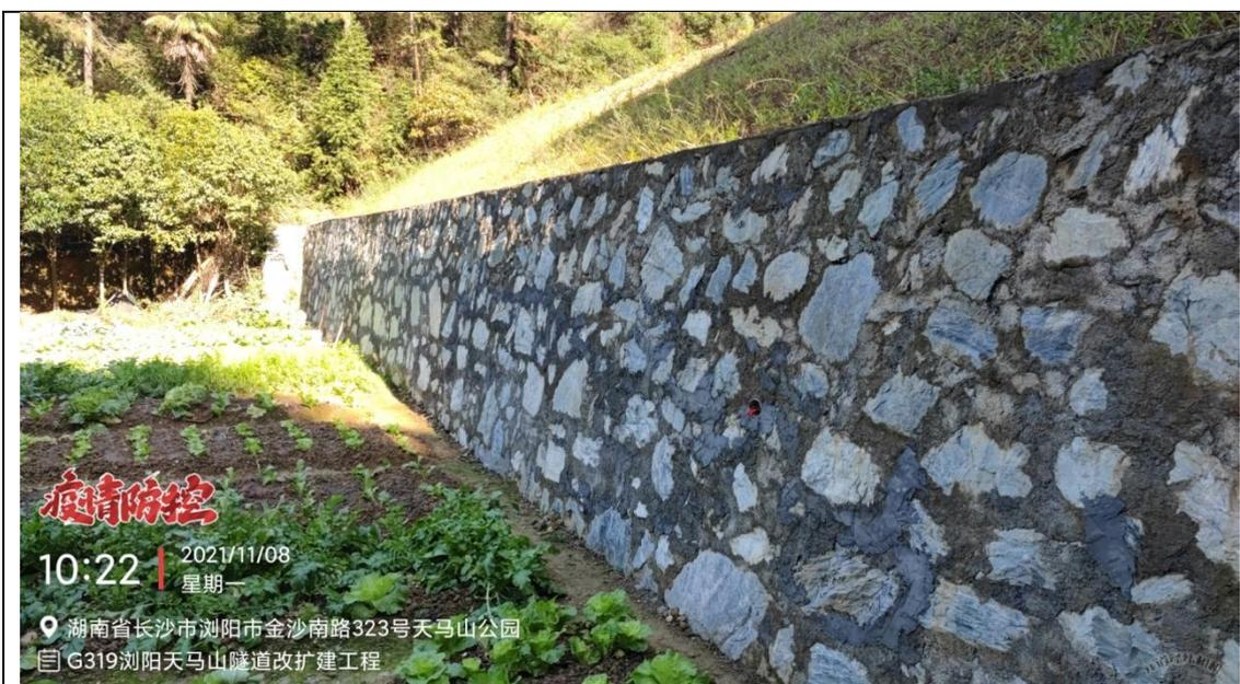
问题：弃土场挡土墙有裂缝。
