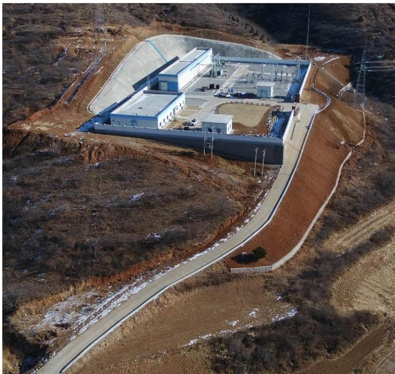
装置室布置在东北侧中部，变压器布置于南侧毗邻 35kV 屋内配电装置，综合楼、水泵房布置在场区的西侧，66kV 配电装置区布置在场区的东南侧。站内道路采用混凝土路面，花岗岩路缘石，站内道路长度为 322m，主要道路宽为 4.0m，次要道路宽为 3.0m，回转半径 7.0m，采用城市型兼做排水用，主干道与支干道环行贯通，运输条件良好。站区内路旁、建筑物旁及其他空闲场地适当种植长青树和草坪以美化环境，升压站内绿化系数为 15%。
