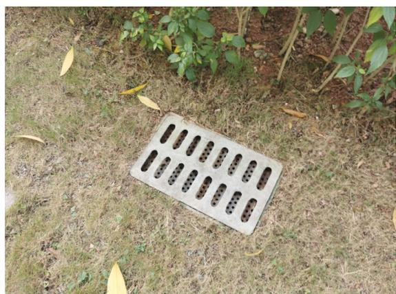
图 11 小区内排水管雨水口现状 1
