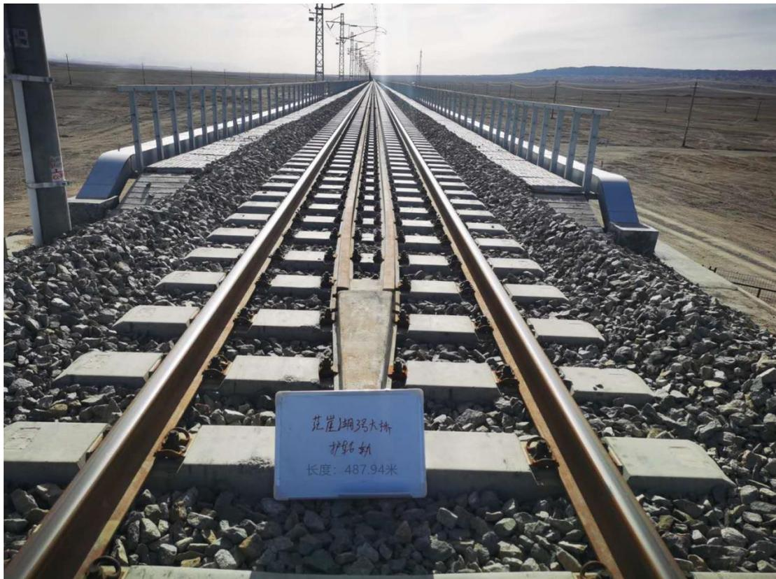
图 10.3-1 现场护轮轨照片
