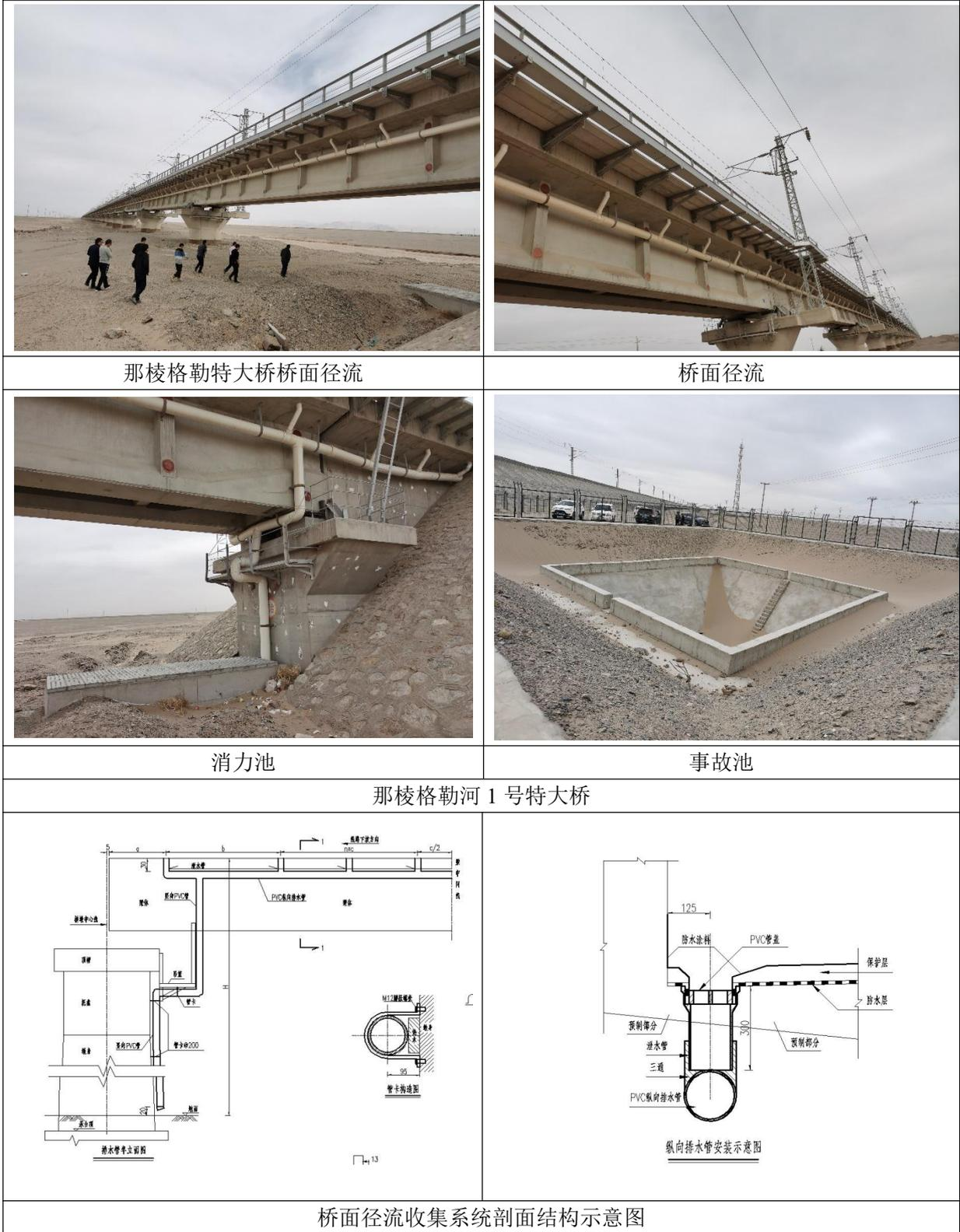
图 10.3-2 验收阶段桥面径流系统照片
