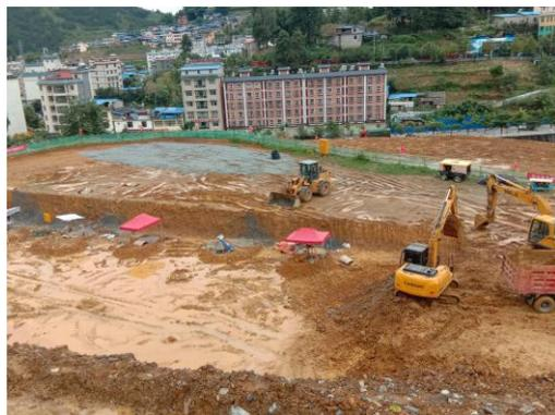
图12 基坑开挖
