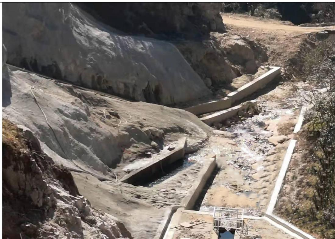
导流输水隧洞出口、溢洪道出口及主坝渗流三角堰
