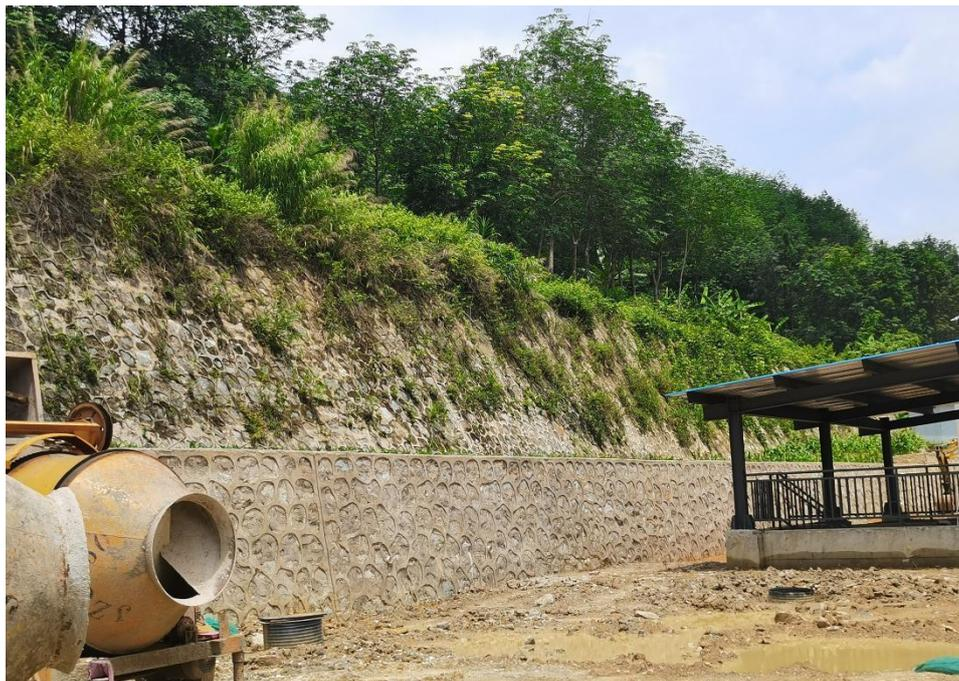
图 1-5 项目西侧原有台地毛石挡土墙（平台上已实施绿化）
